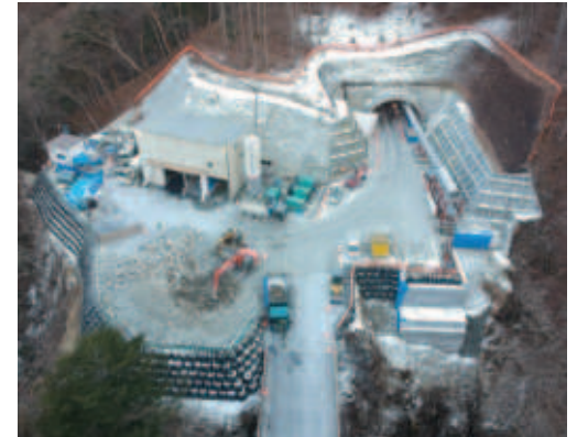
■ 国道411号 一之瀬高橋バイパス 整備中のトンネル
