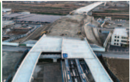
■ 新山梨環状道路 東部区間Ⅱ期(整備中)
