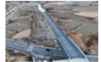
■ 新山梨環状道路 東部区間Ⅱ期(整備中)
