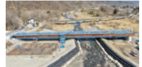
■ (一) 横手日野春停車場線 駒城橋架替
