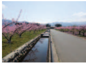
■ 農業用排水路整備
