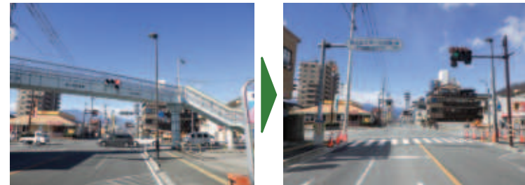
■ 歩道橋の撤去
