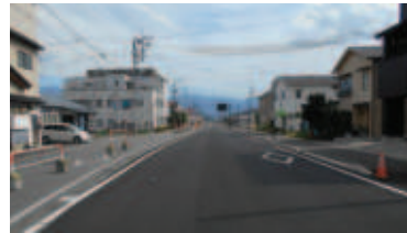
■ (都)山梨市駅南線 整備済区間
