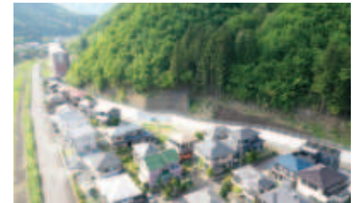
■ 人家を守る急傾斜地崩壊防止施設
