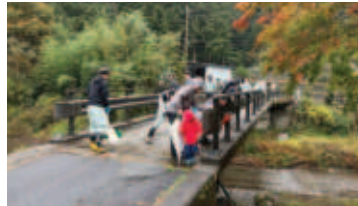
■ 住民参加型の橋梁セルフメンテナンス
