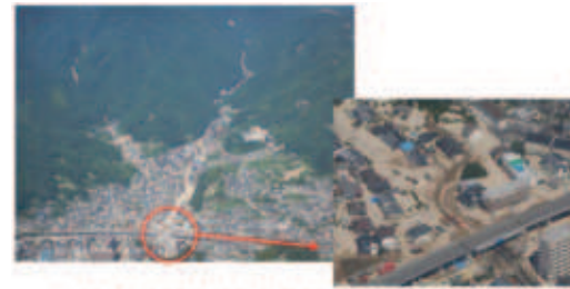
平成30年7月豪雨における土砂・洪水氾濫の発生状況(広島県府市采西条地区) 出典：国土交通省資料
