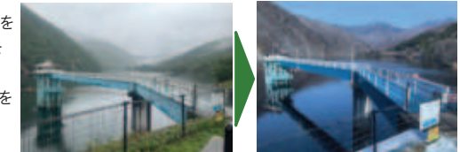
■ ダム取水線の更新
