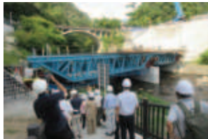
■ 公共事業評価委員会による現場視察
