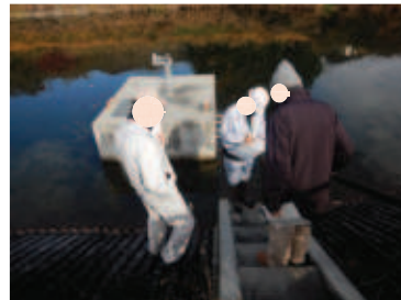
■ ため池サポートセンターによる点検
