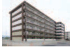
■ 県営住宅の建替
