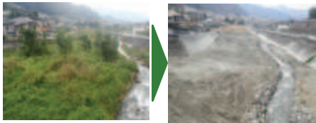
■ 伐木浚渫対策
