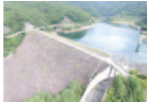
■ ドローンによるダム点検映像
