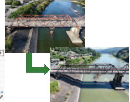
■ 県管理道路における橋梁修繕
