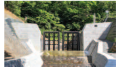
■ 土砂災害を防止する砂防堰堤
