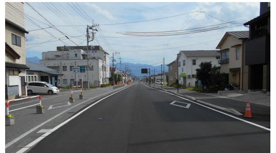
■ (都)山梨市駅南線 整備済区間
