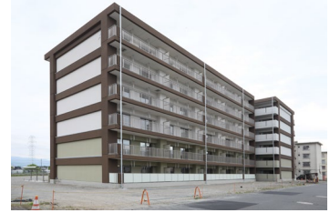
■ 県営住宅の建替
