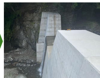
■ 砂防堰堤の改築
