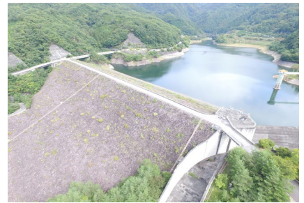
■ ドローンによるダム点検映像
