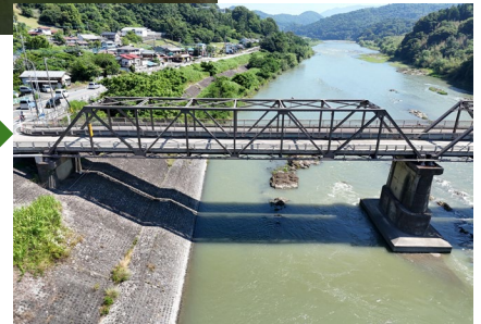
■ 県管理道路における橋梁補修
