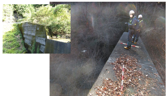
■ ドローンを用いた砂防堰堤の点検
