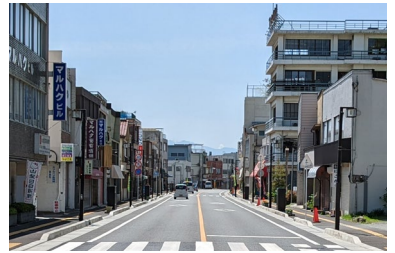
■ 無電柱化された道路
