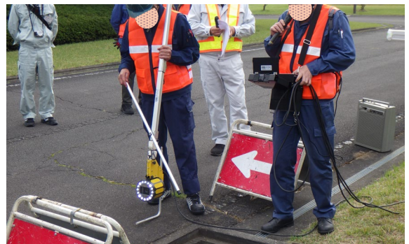
■ 管路管理業協会とのBCP訓練(マンホール入孔訓練)
