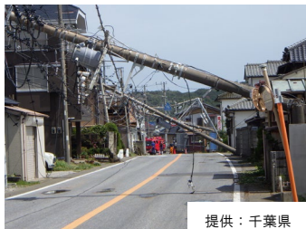
■ 令和元年台風15号による電柱倒壊
