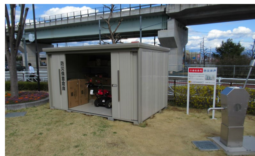
■ 道の駅に整備された防災資材及び防災井戸
