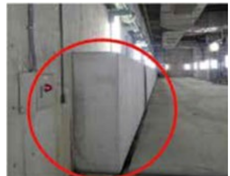
■ 下水処理場の耐震化
