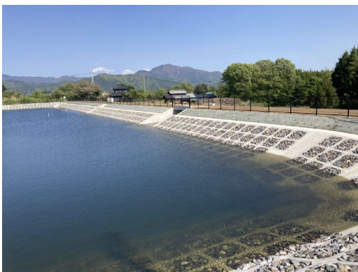
■ 耐震化された防災重点農業用ため池
