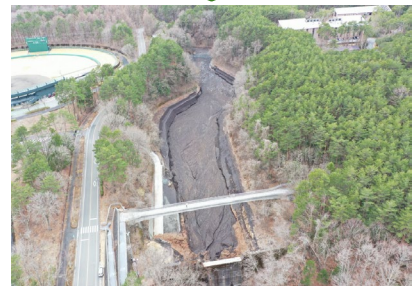
■ 土砂を捕捉した堰堤
