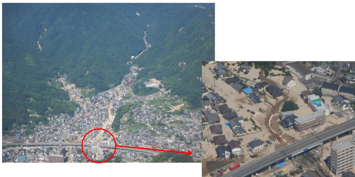
平成30年7月豪雨における土砂・洪水氾濫の発生状況(広島県呉市天応西条地区) 出典:国土交通省資料
