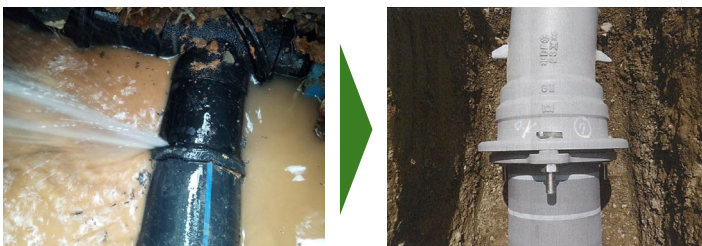
■ 耐震化された水道管
