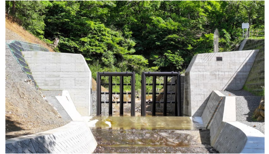
■ 土砂災害を防止する砂防堰堤
