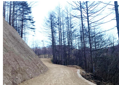
■ 林道及び林業専用道の開設
