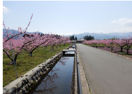
■ 農業用排水路整備
