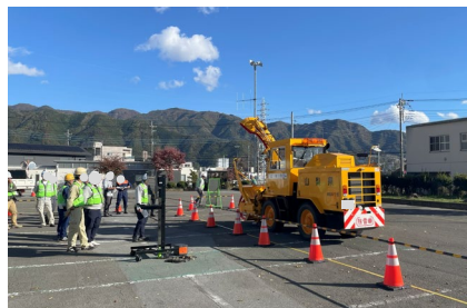
■ 大雪を想定した道路啓開訓練
