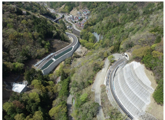
■ 国道300号 中之倉バイパス 供用区間
