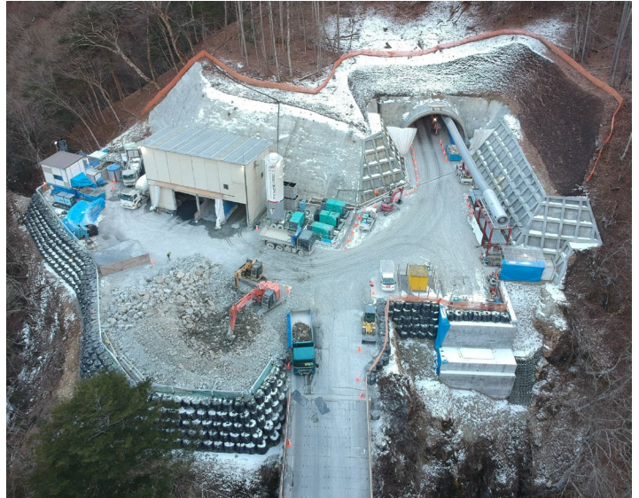
■ 国道411号 一之瀬高橋バイパス 整備中のトンネル
