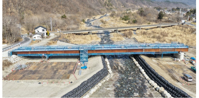
■ (一)横手日野春停車場線 駒城橋架替
