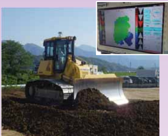
■MGブルドーザによるICT施工
