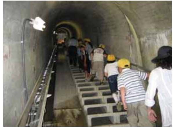
普段立ち入ることが出来ない監査廊を散策
