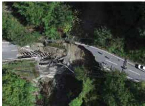
(主)南アルプス公園線(早川町湯島)
