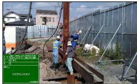
H鋼打設状況
