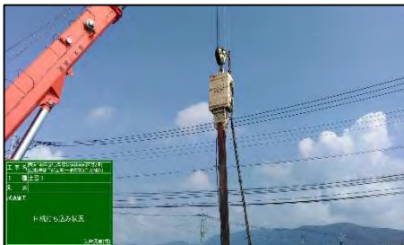
H鋼打設状況
