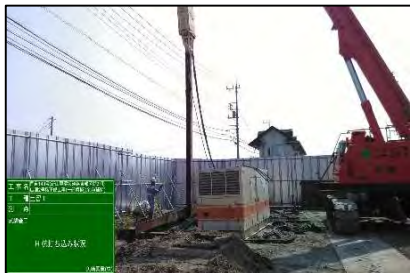
H鋼据付状況
