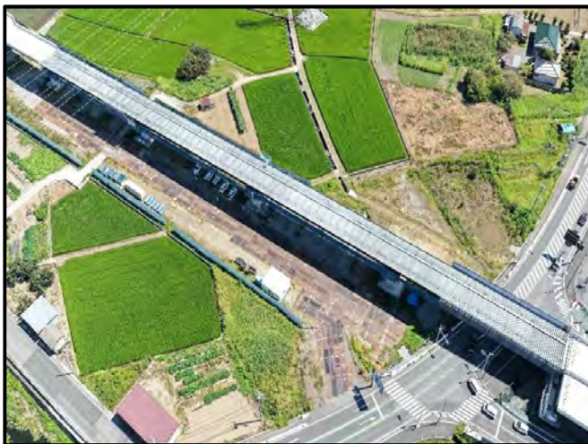
施工状況(架設完了)
