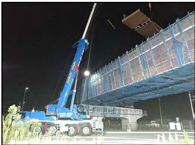
施工状況(夜間架設)
