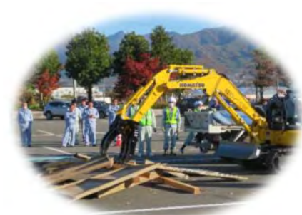
瓦礫撤去状況
