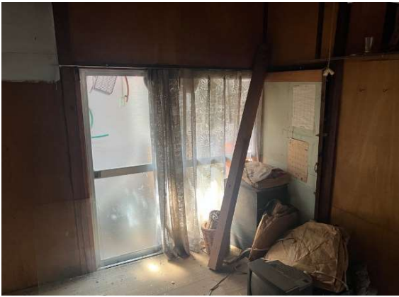
⑨対象土地物件内 東部屋から南西方向
