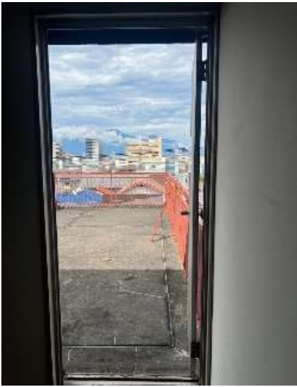
㊹ 4 F内から屋上
