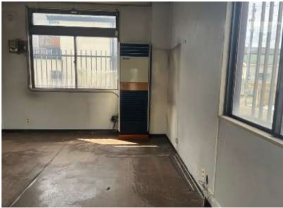
⑮ 1 F フロア内北北東側から南南西方向
