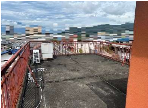
㊻ 屋上部分西側から東方向
