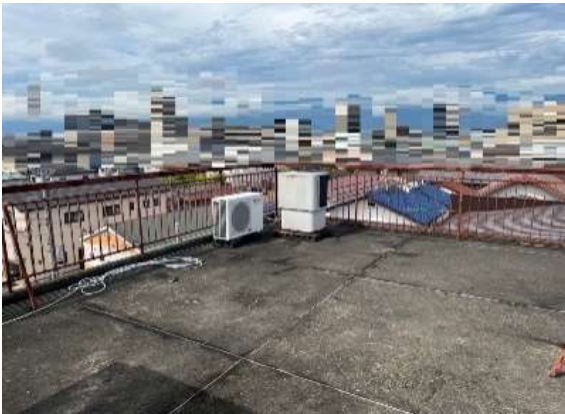
㊺ 屋上部分北西側から南東方向
