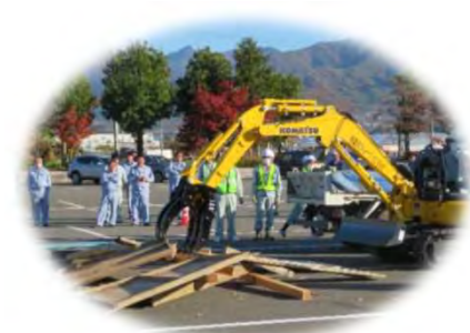
瓦礫撤去状況
