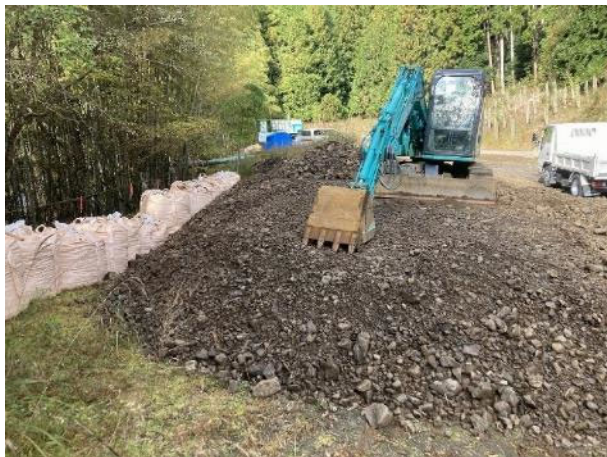
土嚢による土砂流出防止の状況
