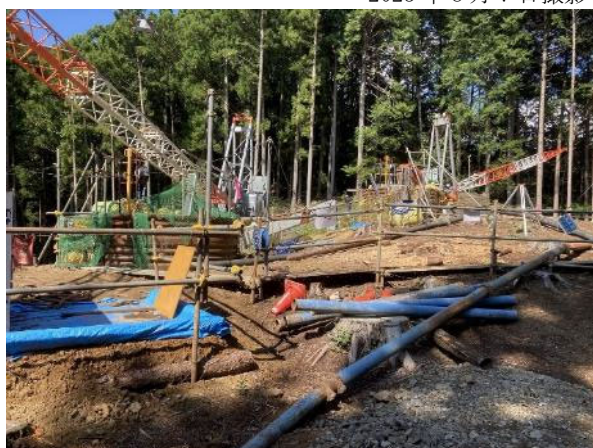
鉄塔基礎 施工中 2024年8月8日撮影
