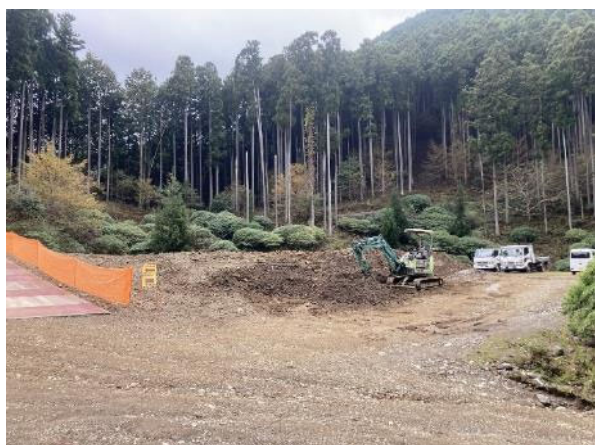
残土処理場 施工中 2024 年 11 月 12 日撮影
