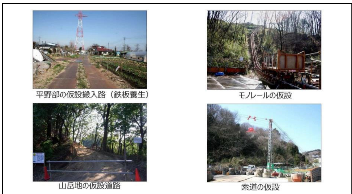
図 1.4.2-1 工事状況の例（仮設工事・資機材の運搬）
