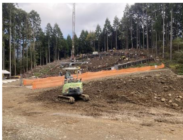
鉄塔基礎 施工中 2024年11月12日撮影
