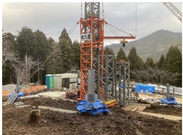
鉄塔基礎 施工中 2024年12月10日撮影
