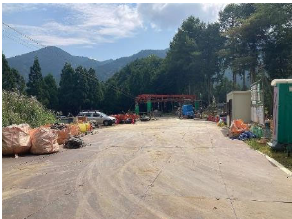
索道基地 施工後 2024年8月9日撮影
