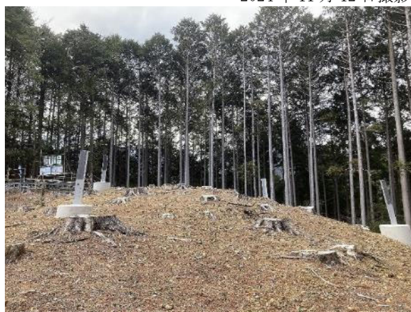
鉄塔基礎 施工後 2024年12月10日撮影
