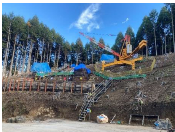
鉄塔基礎 施工後 2024年12月7日撮影
