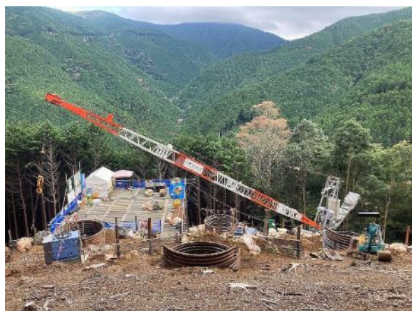
鉄塔基礎 施工中 2024年9月13日撮影
