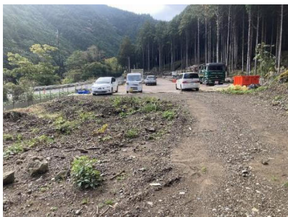
残土処理場, ドラム場 施工中 2024 年 11 月 12 日撮影
