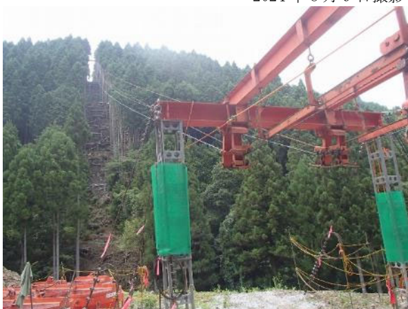
索道 施工後 2024年7月18日撮影
