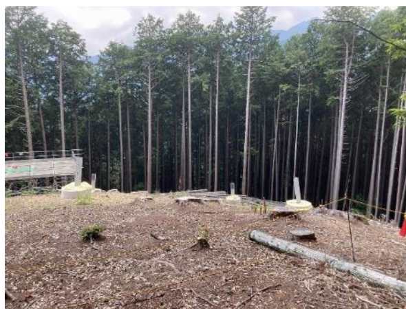
鉄塔基礎 施工後 2024年7月26日撮影
