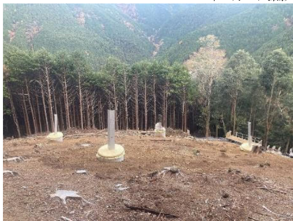
鉄塔基礎 施工後 2024年12月10日撮影
