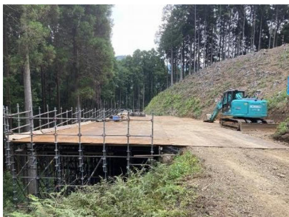
仮設工事 施工後 2024年8月7日撮影
