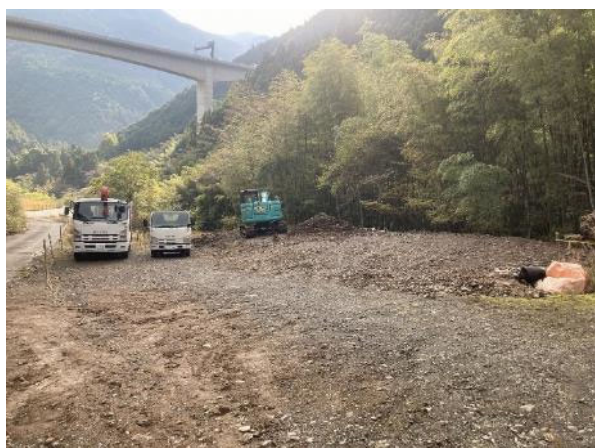
残土処理場 施工中 2024 年 11 月 12 日撮影
