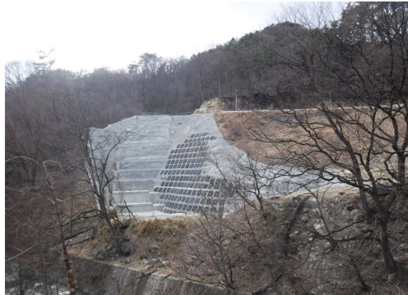
②擁壁工区間全景
