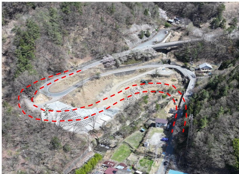
①工事着手状況全景
