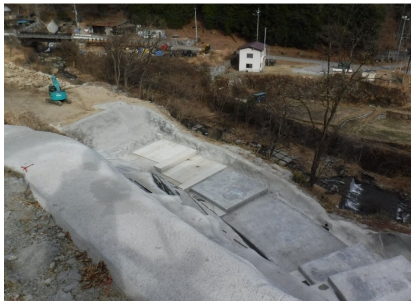
③擁壁工施工状況
