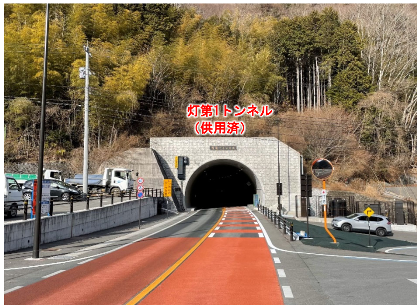
⑦ 進捗状況(灯第1トンネル坑口付近) (完成)
