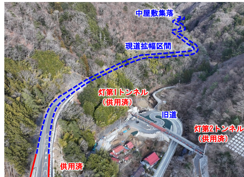
⑧ 進捗状況(供用区間～未改良区間)
