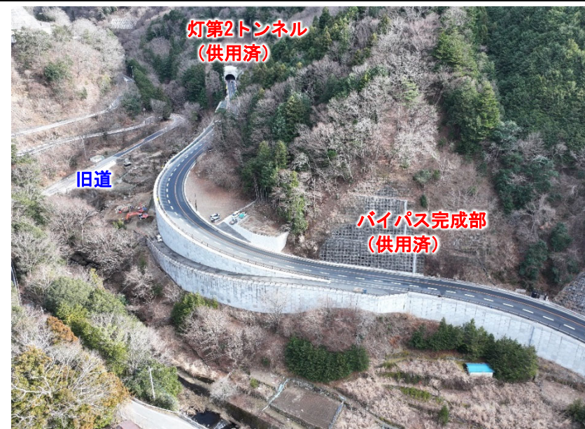
⑥ 進捗状況(バイパス区間中間部付近) ～ヘアピンカーブの現道とバイパス区間～ (完成)
