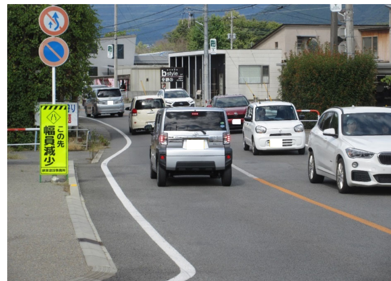
②未改良区間の状況
