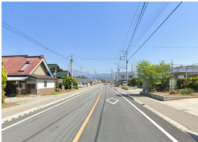
①改良済み区間の状況
