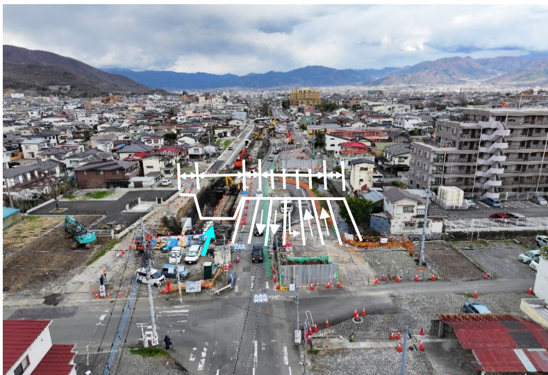
③城東工区 施工状況（終点から起点）
