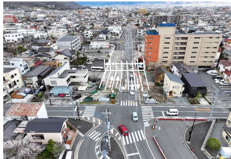
④中央5丁目工区 施工状況（終点から起点）
