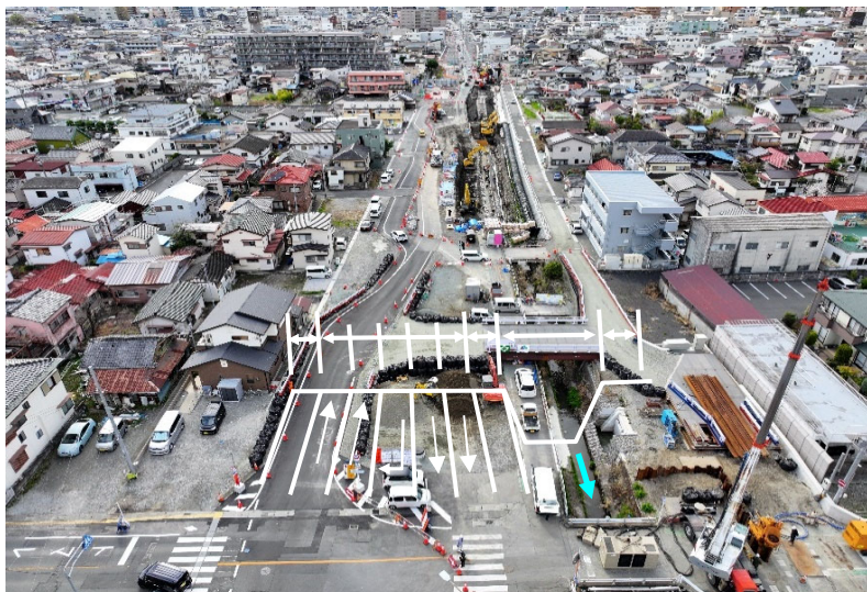
①城東工区 施工状況（起点から終点）
