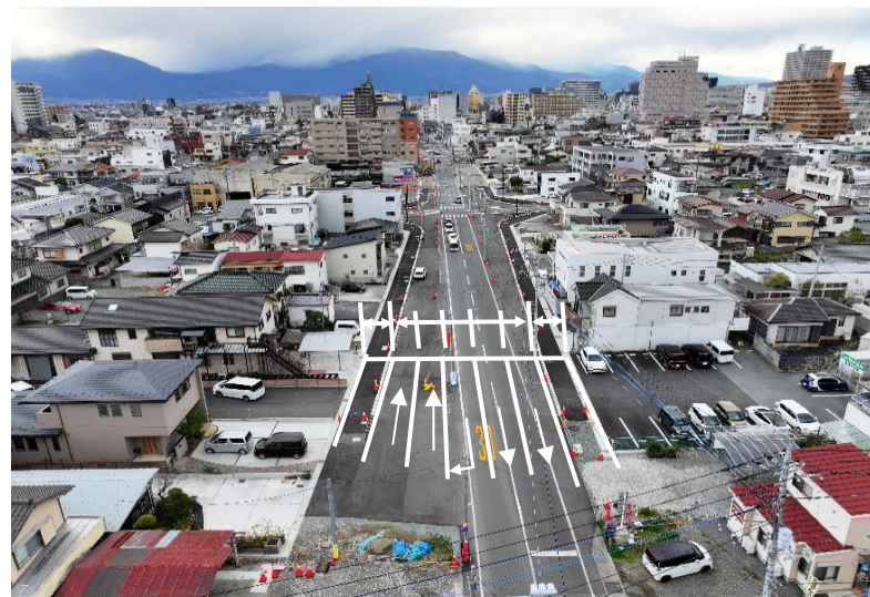
②中央5丁目工区 施工状況（起点から終点）
