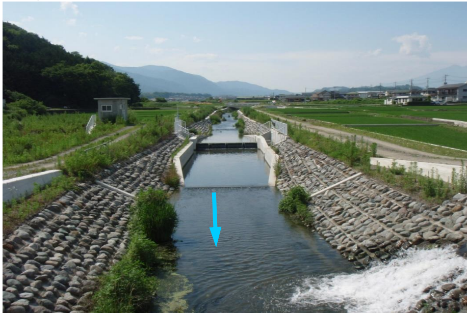
写真① 県道「古川橋」より上流の状況（改修後）取水堰に魚道を設置
