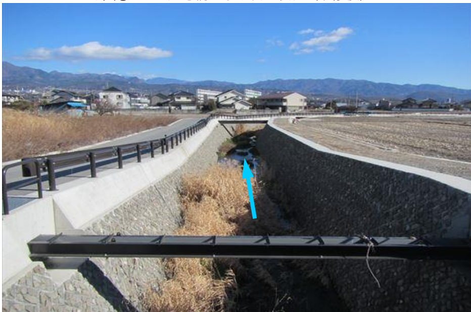
写真③ 古川9号橋より下流の状況（改修後）
