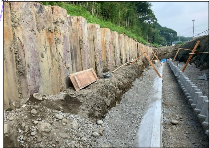
矢板土留めによる施工状況 (No.67から上流)
