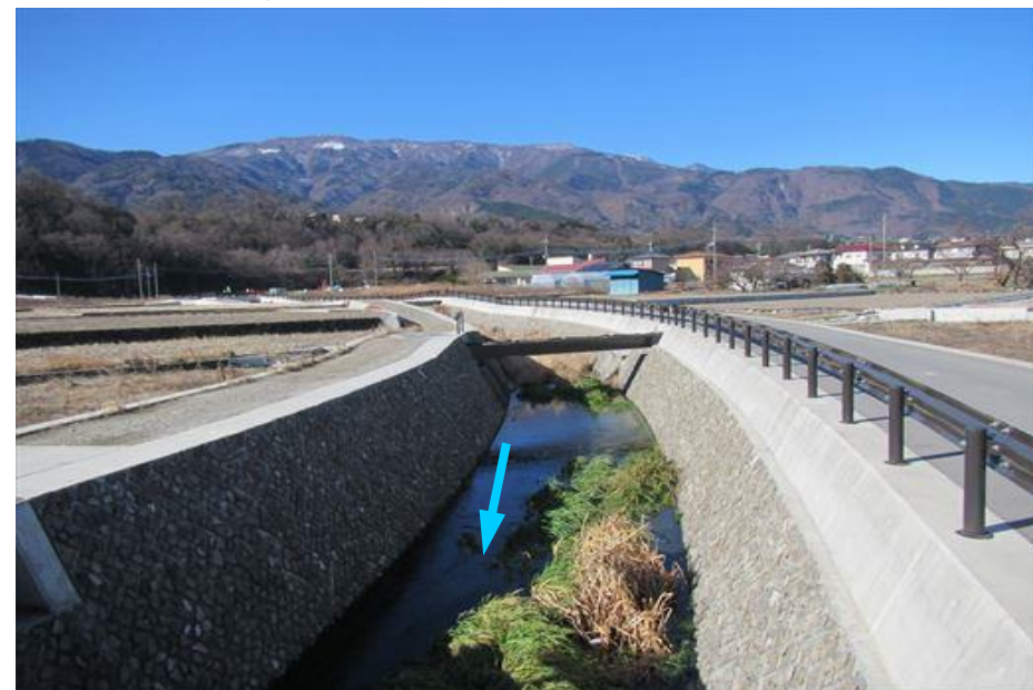
写真② 古川8号橋より上流の状況（改修後）
