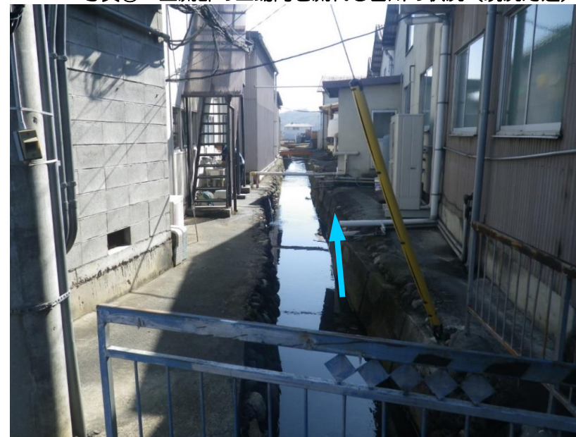
写真④ 上流部の工場間を流れる古川の状況（現況河道）
