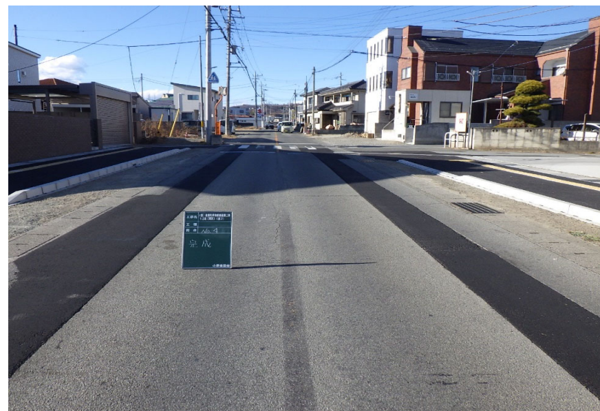
④令和7年3月現在の整備状況（終点側）
