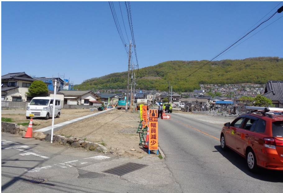
② 一部工事着手状況
