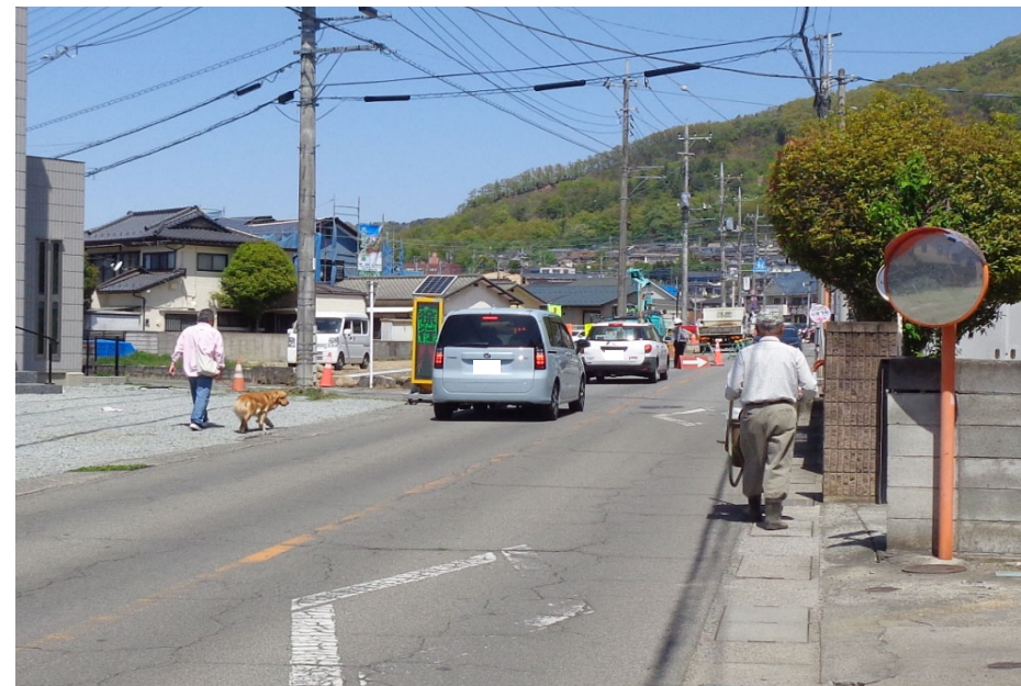
③ 路肩・歩道がなく歩行者の通行が危険な状況
