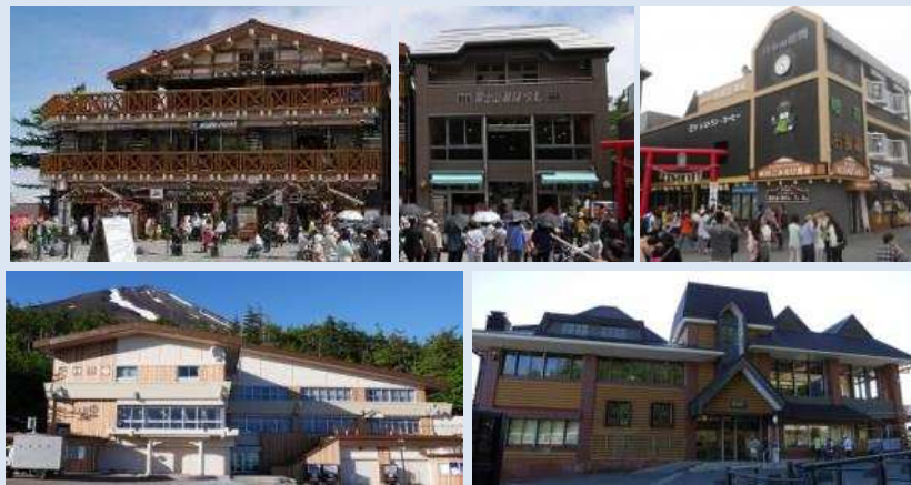
現在の主な民間・公共施設の状況（五合目）
