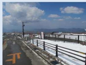
色彩に配慮したガードレール
