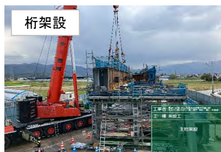
現場施工状況
