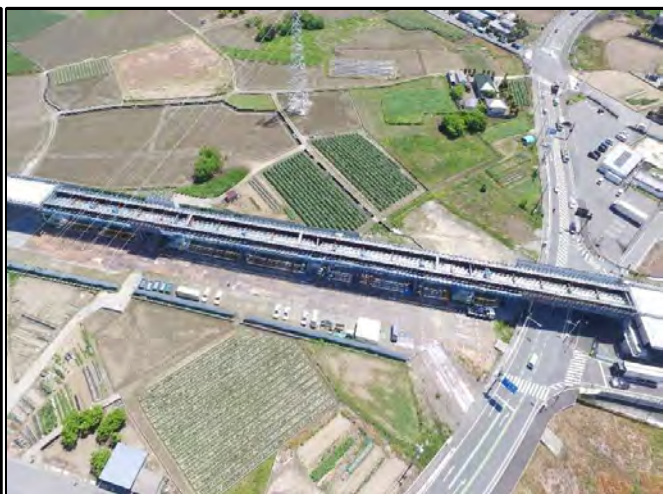
施工状況(架設完了)
