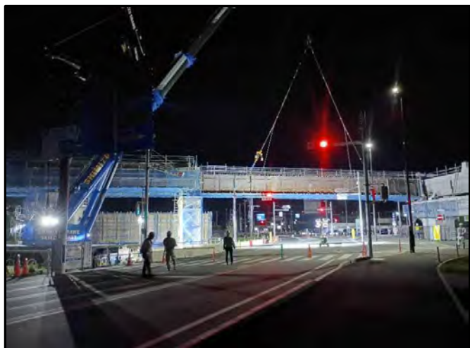
施工状況(夜間架設)
