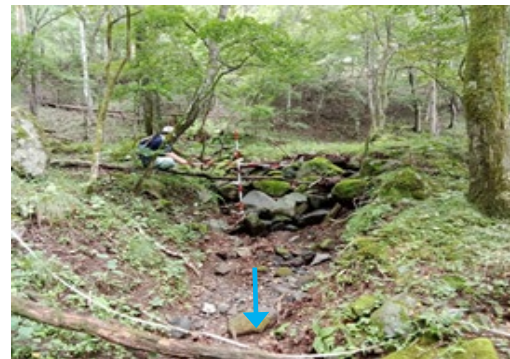
① 荒廃状況 (土砂堆積)
