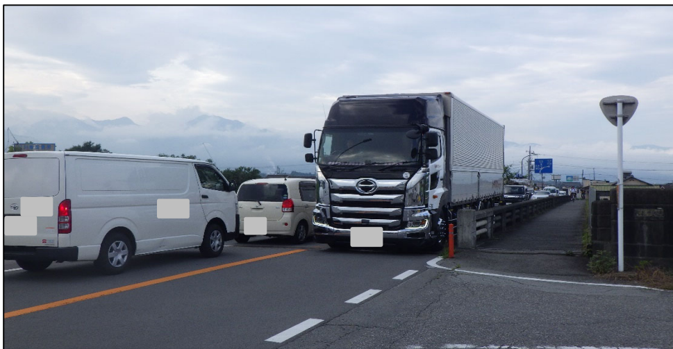
①幅員狭小・交通状況（現橋）
