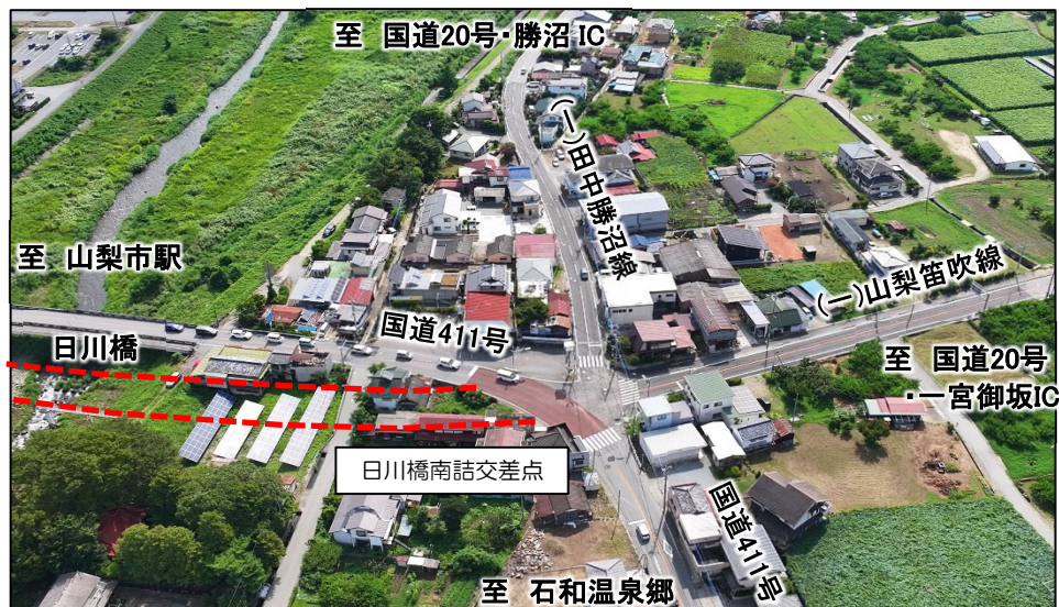
③取付交差点状況
