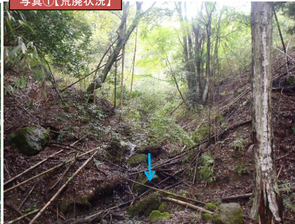
写真①【荒廃状況】
