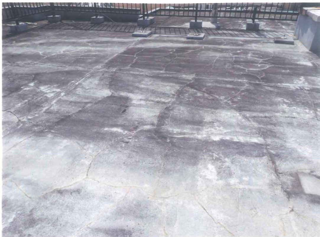
対象不動産の様子(屋上)
