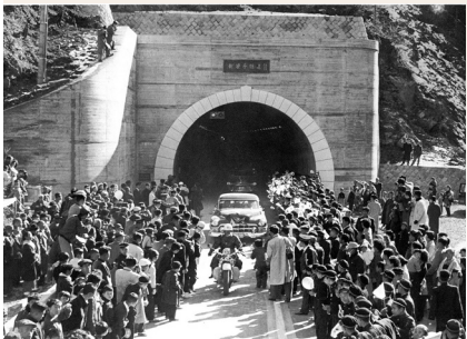
新笹子トンネル開通
