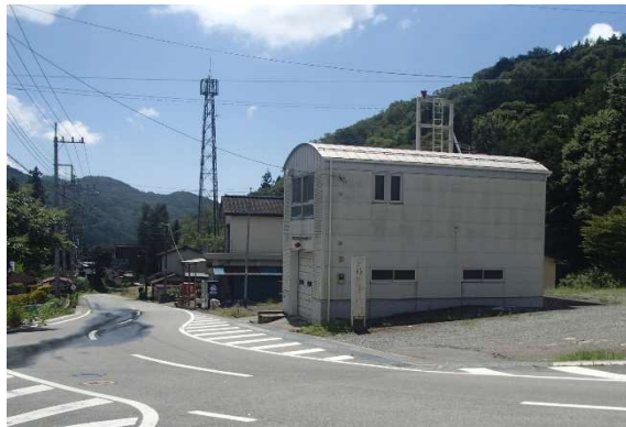
②ため池下流には人家があり、大規模地震の際には甚大な被害のおそれがあるため、早急に対策を講じる必要がある。
