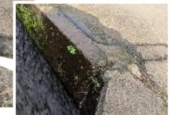
水路の経年劣化の影響で、漏水が発生し水路補修などの維持管理に苦慮している。
