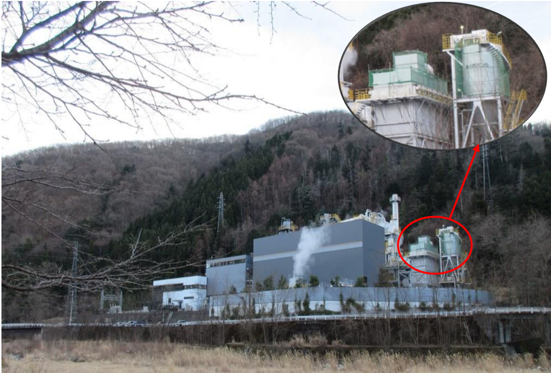
図7 2024年1月カモフラージュ設備施工後の灰バンカ、バグフィルター上部計算図
