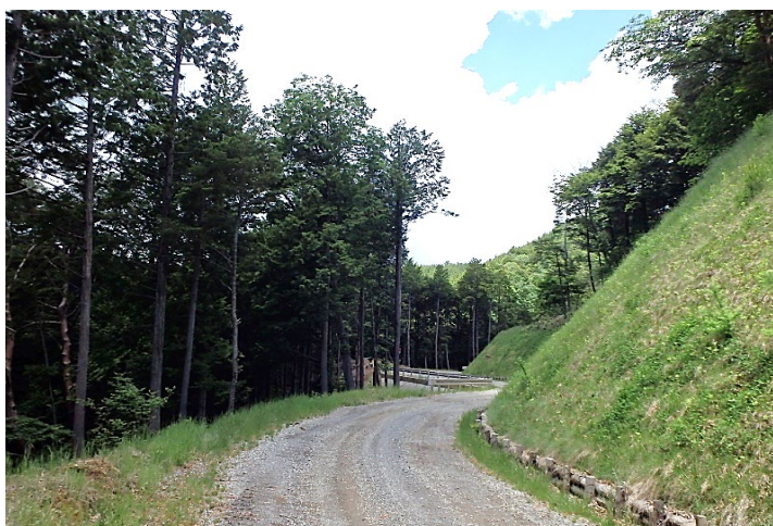
② 完成状況
