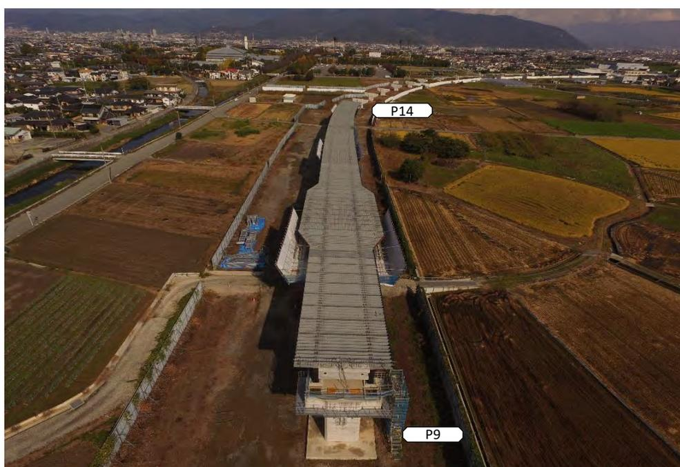
橋形式：鋼5径間連続合成少数鈹桁橋
