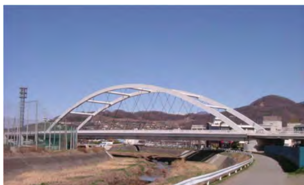
写真 2.5 橋梁の外部景観 ※参考文献 2-2 より（甲府市・国道 411 号「城東大橋」）
