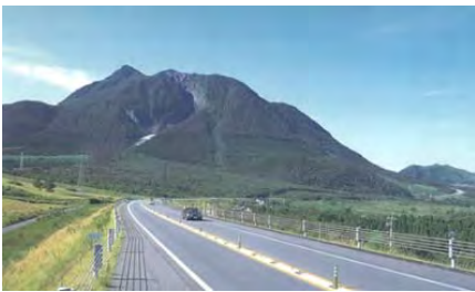
写真 2.15 山アテによる地域資源の強調 ※参考文献 2-14 より（大分・大分道）
