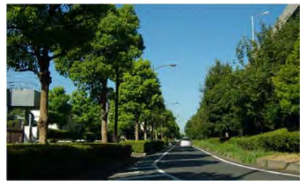
写真 2.19 高木植栽による遮音壁の消去 ※参考文献 2-15 より
