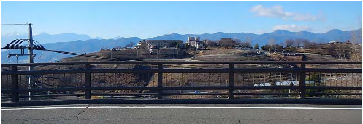
写真 2.8 眺望に配慮した防護柵 鉄道駅の正面に広がる盆地景観をアイレベルに取り込むため、透過性のある防護柵が採用され、視軸線阻害を最小限としている。 (甲州市・勝沼ぶどう郷駅前)
