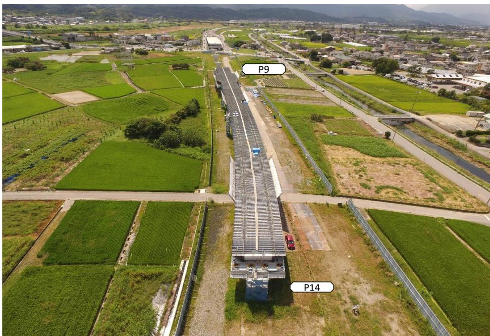
橋形式：鋼5径間連続合成少数鈹桁橋
