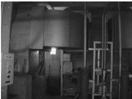
図23 煙突室 (煙突基部空間)
