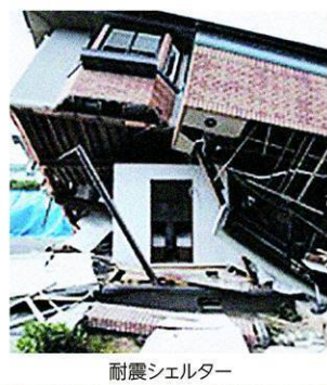
今年1月1日に発生した能登半島地震。被災地では旧耐震基準の建物の倒壊が多発した=石川県輪島市内(山梨県提供)
