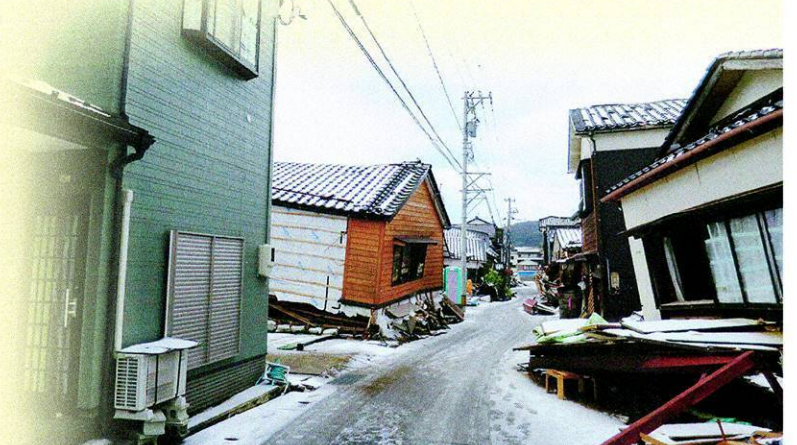
今年1月1日に発生した能登半島地震。被災地では旧耐震基準の建物の倒壊が多発した=石川県輪島市内(山梨県提供)
