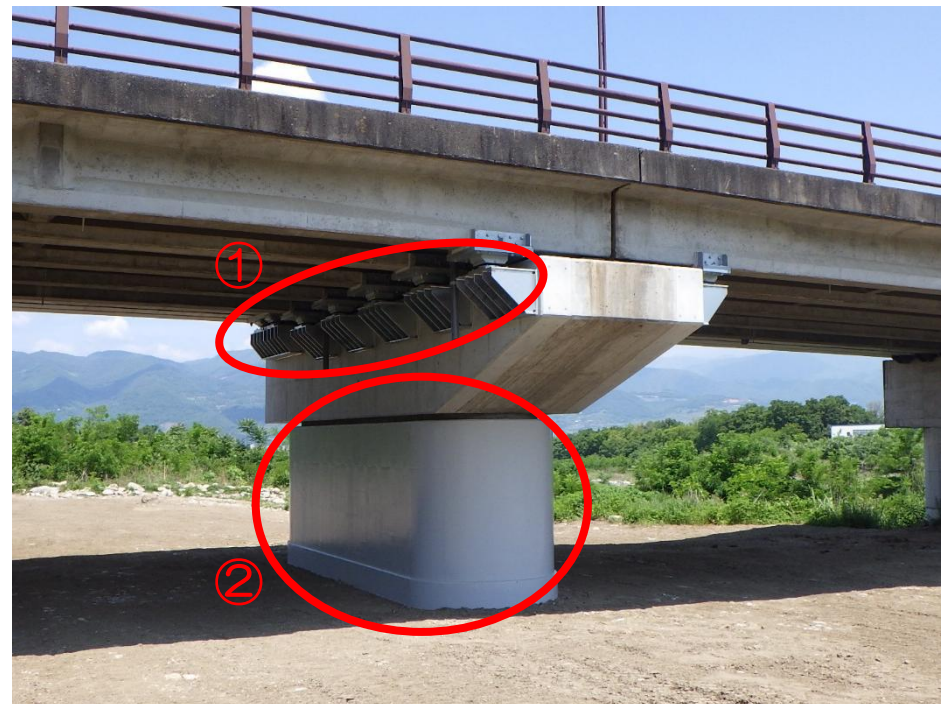
(一) 山梨笛吹線 四ノ橋 (整備後)
