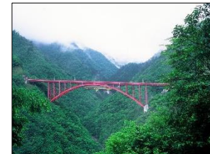
東沢橋（北杜市）
