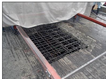
悪いコンクリートを取り壊して
