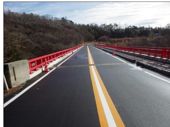
修繕工事の完成
