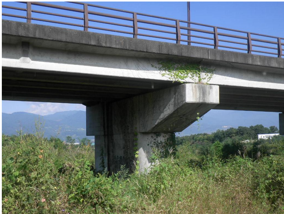
(一) 山梨笛吹線 四ノ橋 (整備前)
