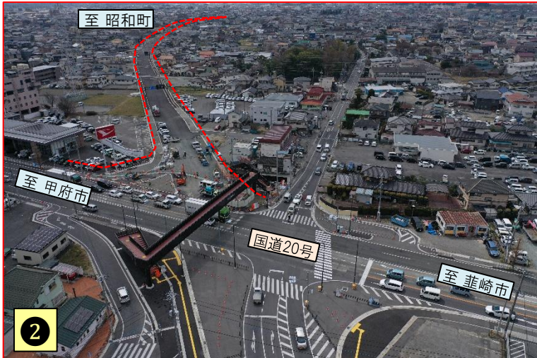
整備中区間の状況
