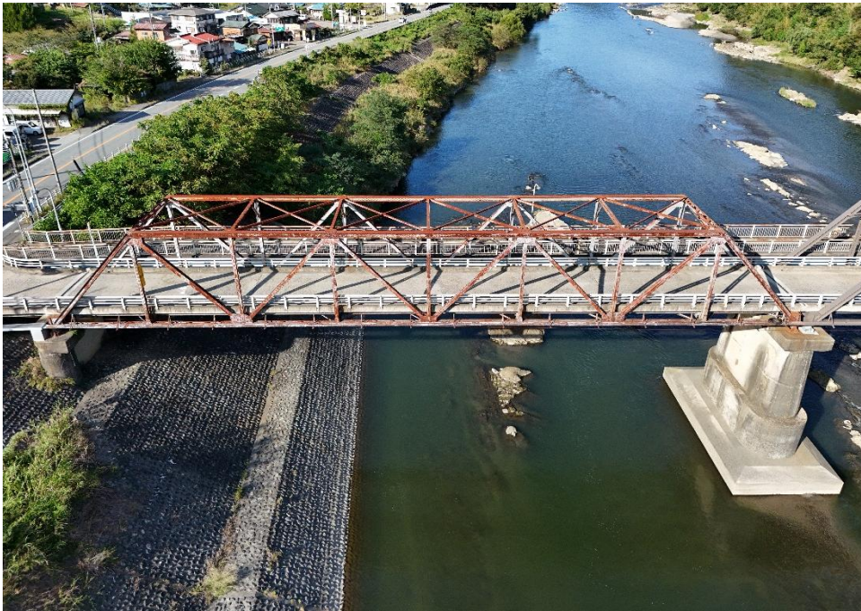
（一）下部飯富線 飯富橋（整備前）
