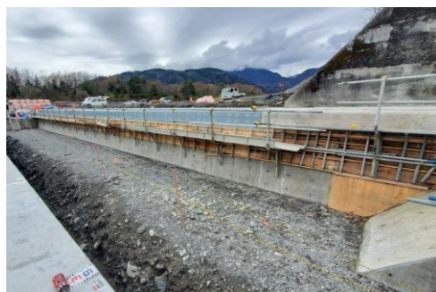
管路の埋設工事
