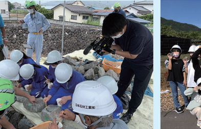
小学生の柵形堤防の石積み修復体験
