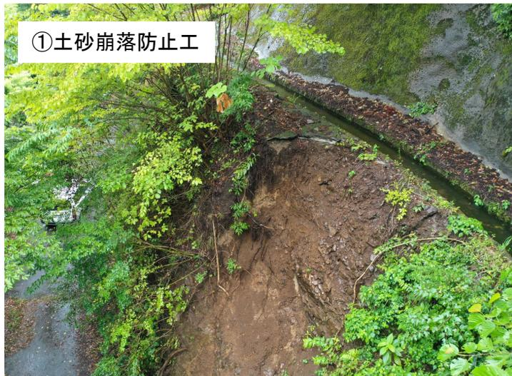
豪雨により土砂が崩落し水路脇の法面が不安定となっており、浸食がさらに進むと水路本体も崩れるおそれがある。
