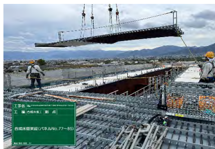
合成床版敷設
