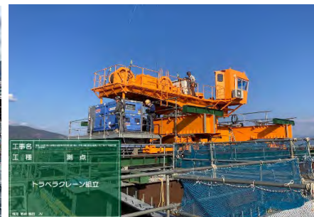
トラベラクレーン組立
