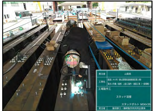
橋桁製作状況
