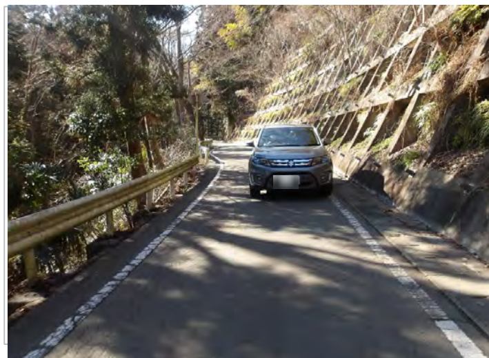
③ すれ違い困難 (山間部)
