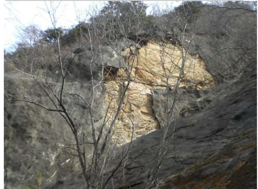
④整備前旧道法面上部のモルタル剥離状況
