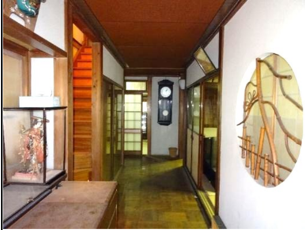
右手は座敷。丸窓の内側は引分け障子。
