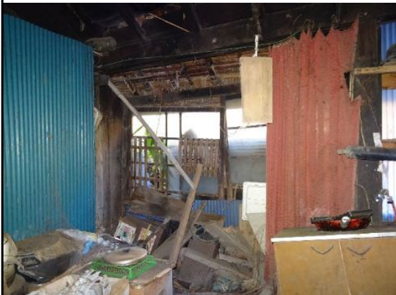
台所 出窓部分
