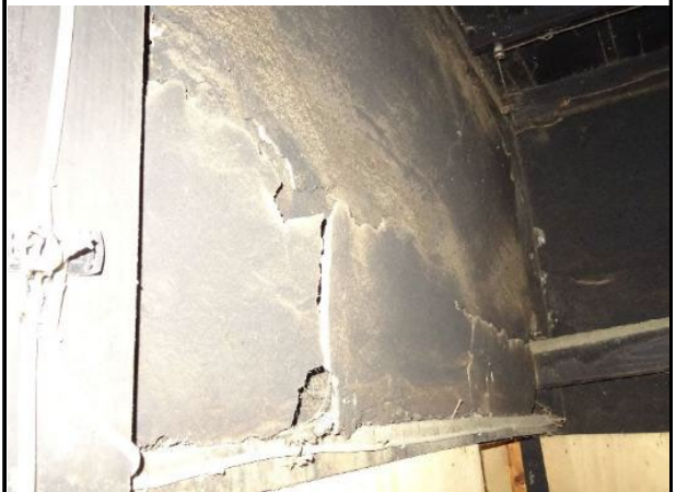
土間 北面土壁
