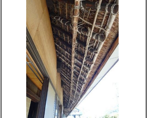
東側軒下 茅葺があらわになっている
