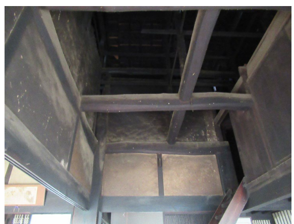
土間上部吹き抜け・2階入り口
