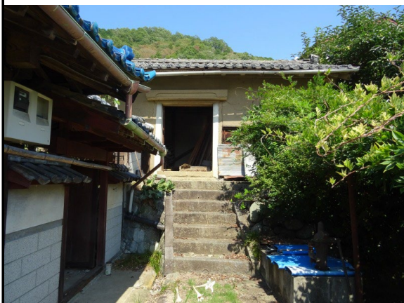
二ノ蔵 西外観
